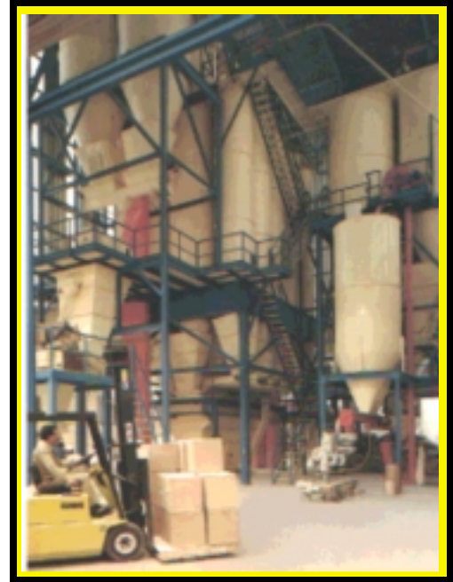
Instalación de dosificación.
